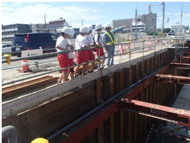
工事現場見学の様子
