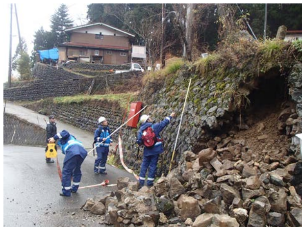
被災状況調査の様子①
