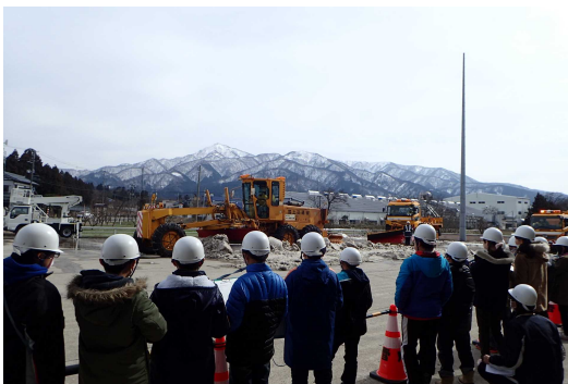
除雪機械のデモンストレーション
