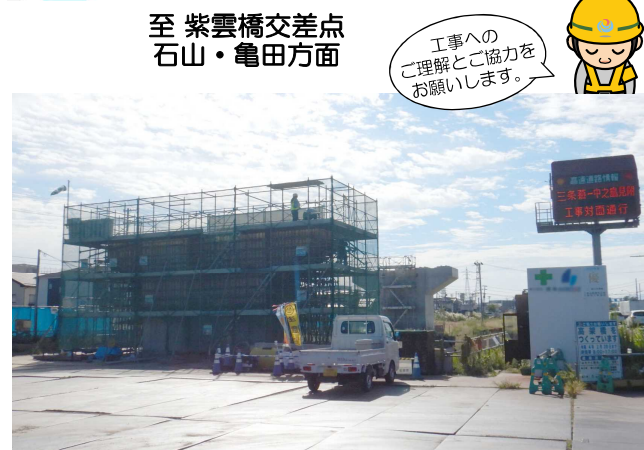
栗ノ木バイパス沿線では、立体道路の5つの橋脚工事を年内完成に向けて実施中です。
