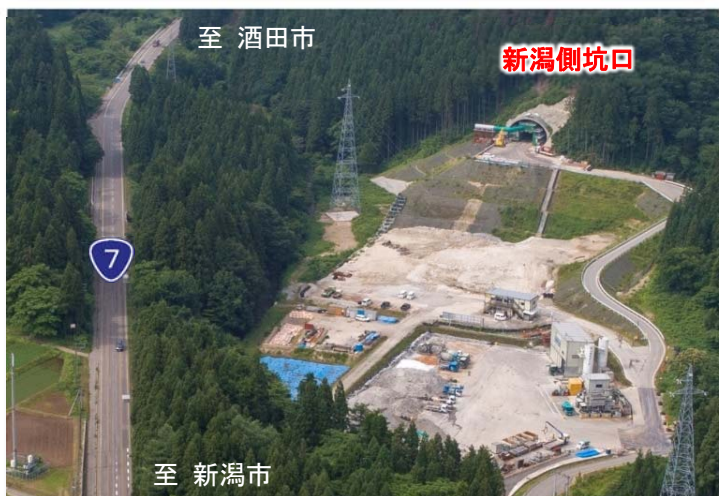
起点側 (新潟側) 掘削開始地点
