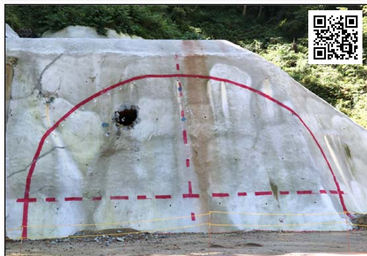
(仮称)1号トンネル貫通の瞬間 (酒田側より撮影)
