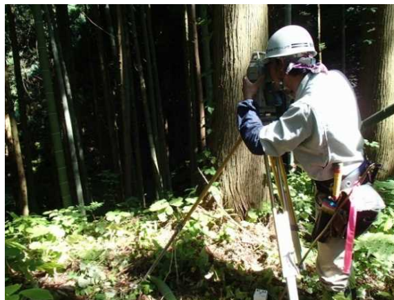
基準点測量の作業状況(村上市大須戸地内)
