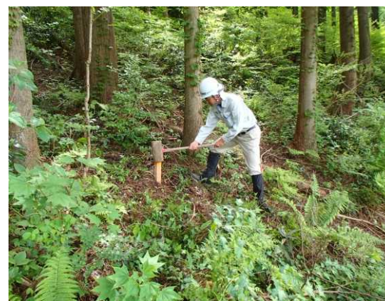
幅杭設置の様子(山地部)
