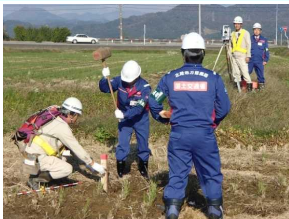
中心杭の設置
