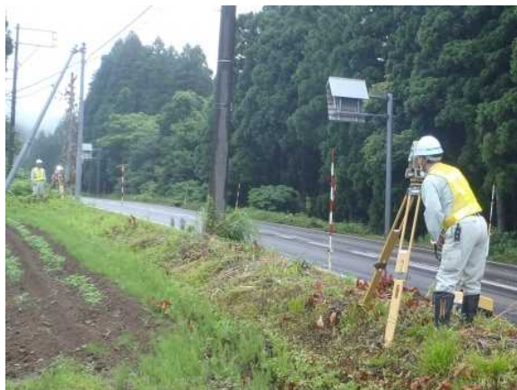
基準点測量の作業状況(村上市大須戸地内)
