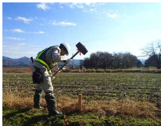
幅杭設置の様子(圃場部)
