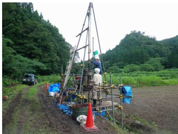
ボーリングの状況
