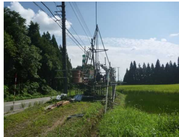
ボーリングの状況
