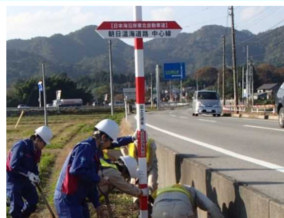
路線標識の設置
