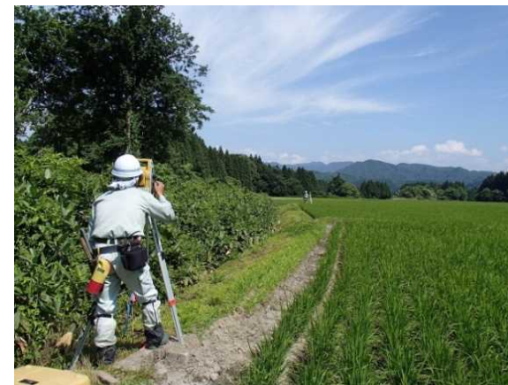
基準点測量の作業状況(村上市塩野町地内)
