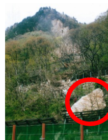
道路の直近まで落石が接近（平成7年の落石）
