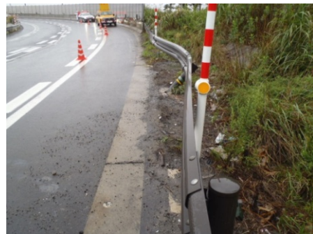
【参考】事故によるガードレールの損傷
