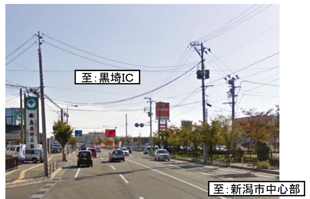
▲現況(電柱、電線の状況)
