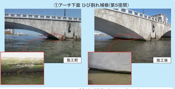
アーチ下面のひび割れ補修を行いました。 【10月完了】
