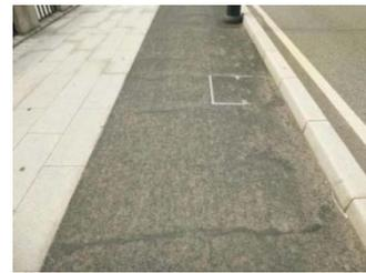
④歩道舗装補修(ひび割れ、段差)
