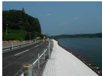
災害復旧状況(H26.7.28撮影)
