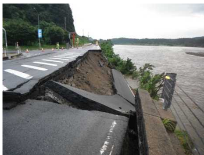
被災状況(H25.7.18撮影)
