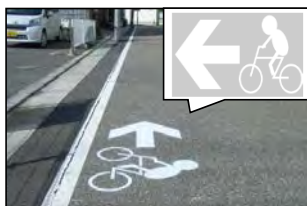
②自転車に車道の左側を通行するよう促す路面表示(車道)
