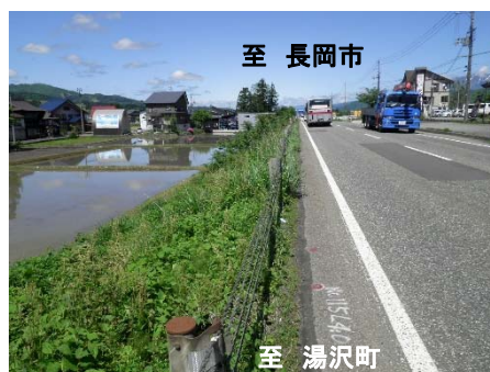
歩道が未整備である
