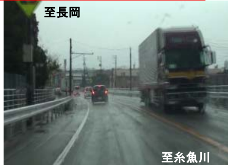
カーブによる前方(交差点)視認性不良
