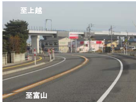
視認性の悪いカーブ区間
