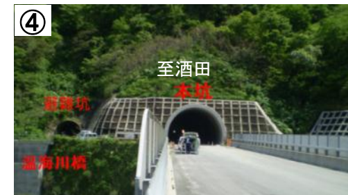
④ 日沿道温海トンネル(南側坑口) 至酒田
