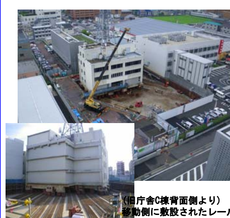
旧庁舎C棟：杭を切断後、移動装置と移動用 レールに搭載された基礎
