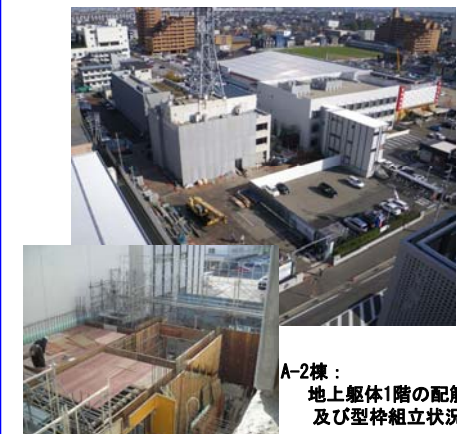
A-2棟： 基礎配筋+型枠組立 状況
