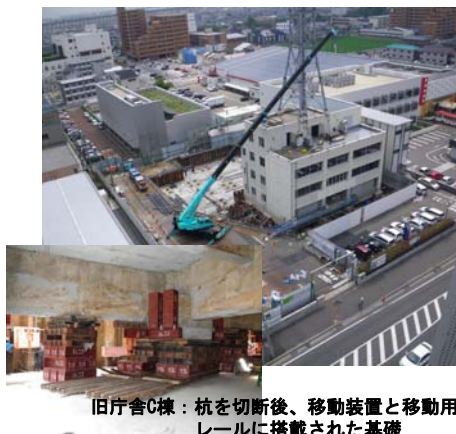
掘削：旧庁舎C棟下部 施工状況
