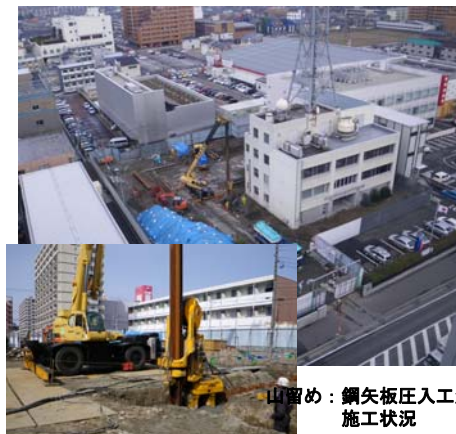
杭：中堀拡大根固工法 施工状況
