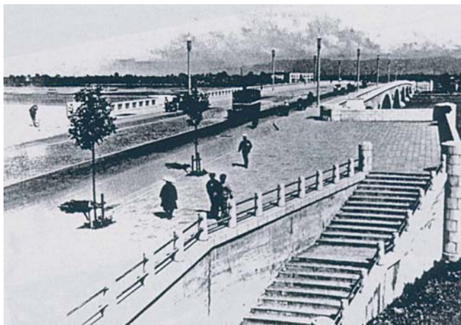
建設当初の橋詰広場
