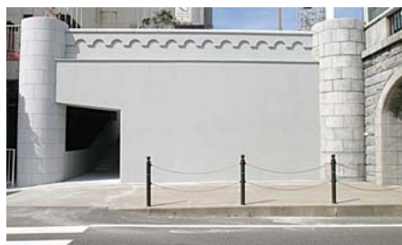
復元された隅柱（左）と親柱（右）
