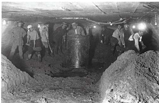
潜函工事の様子
