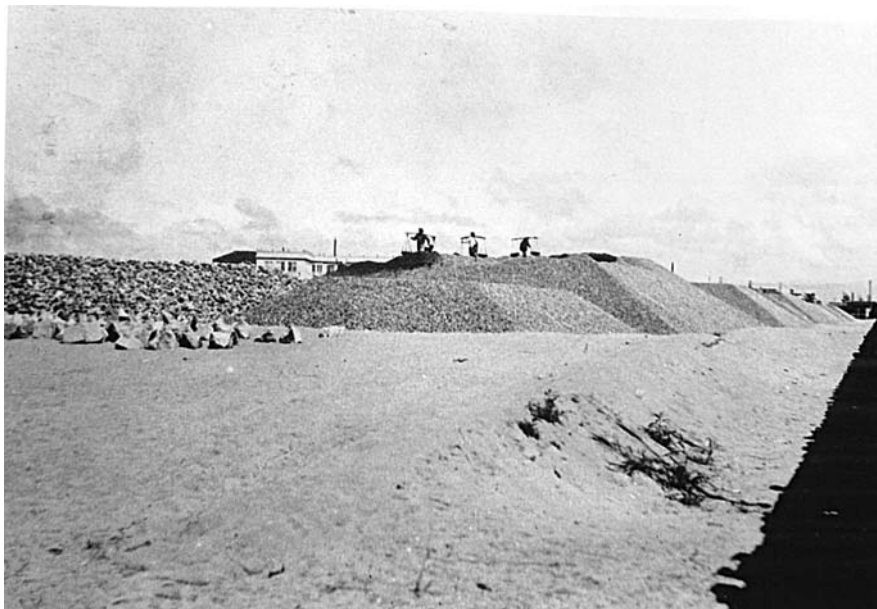
基礎工事で採掘した砂
