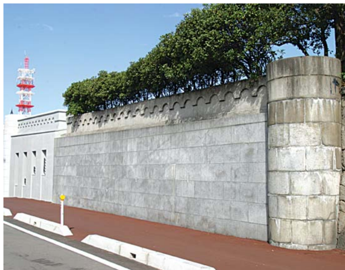
建設当初からの隅柱
