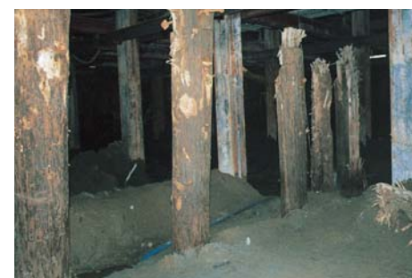
発見された杭
