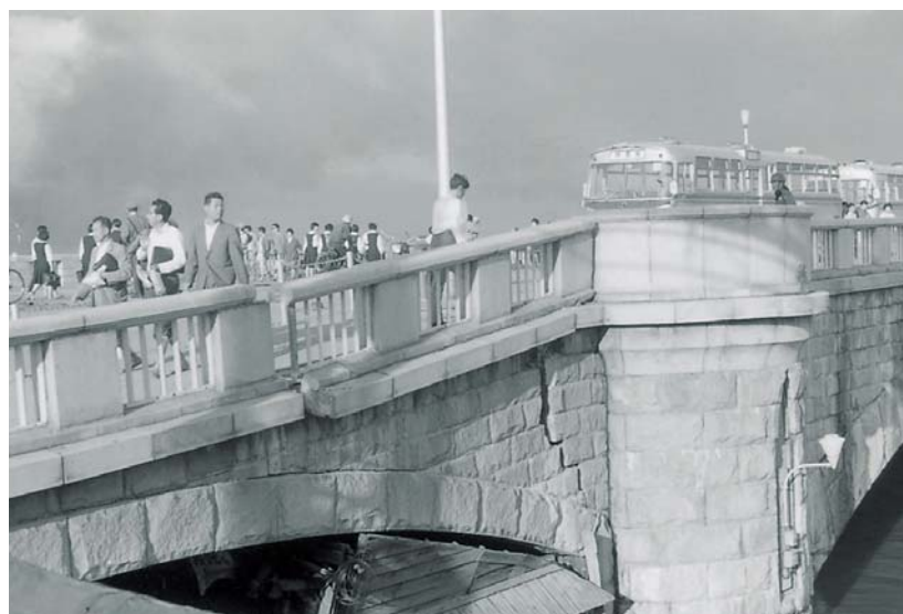
そんしょう 損傷した萬代橋取付部
