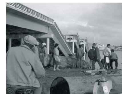
くずれ落ちた昭和大橋
