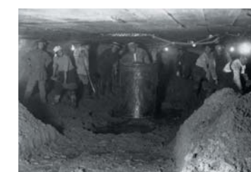
げんば 工事現場の様子
