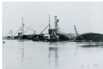
▲建設中の萬代橋
