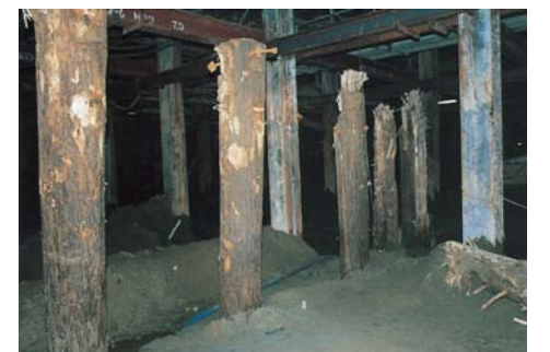
▲発見された杭
