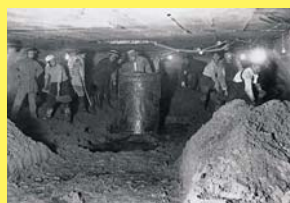
▲掘削を行う潜函夫
