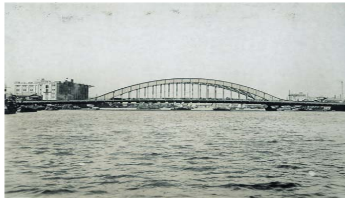
▲災害復興事業によって架けられた永代橋(東京)
