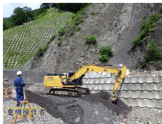
無人化施工（土工）
