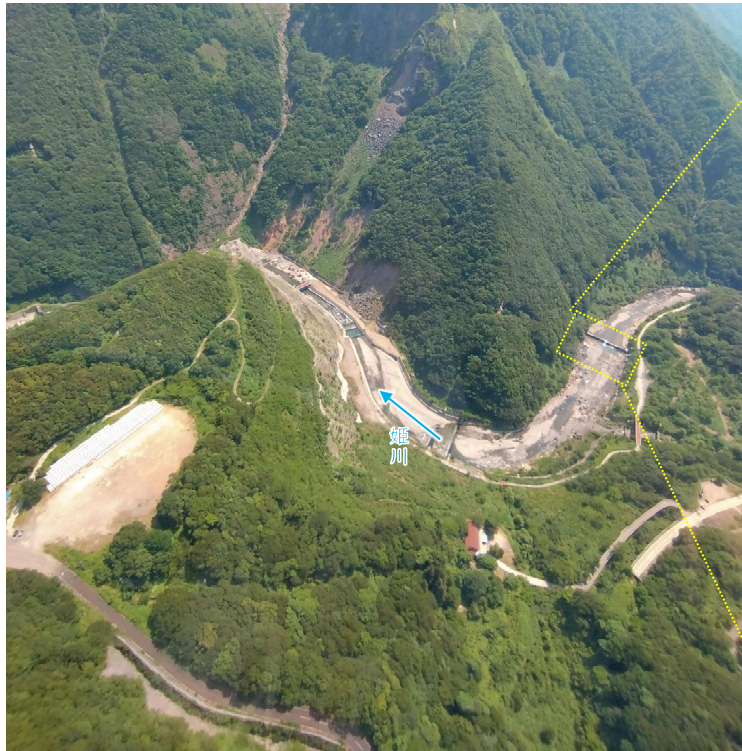
葛葉上流第4号床固工
