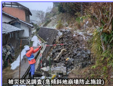
被災状況調査(急傾斜地崩壊防止施設)
