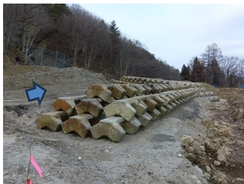
仮設導流堤(ブロック約300個)
