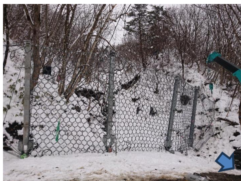
アンカーネット式構造物
