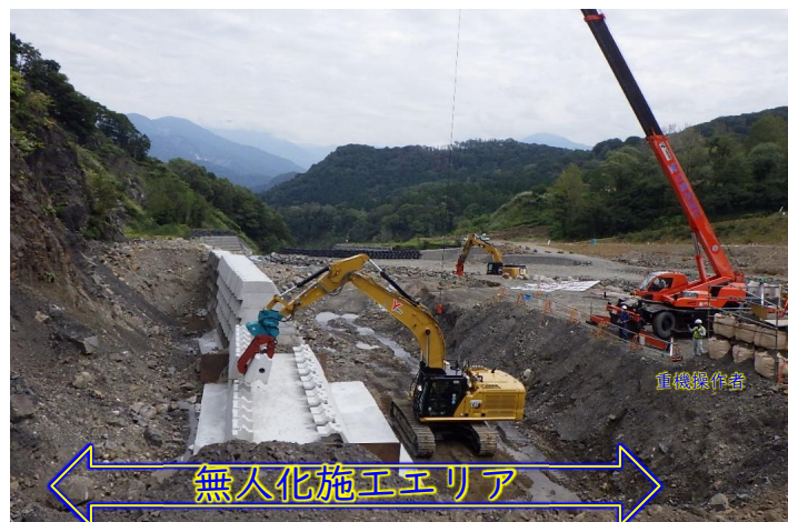
無人化施工（型枠ブロック据付）
