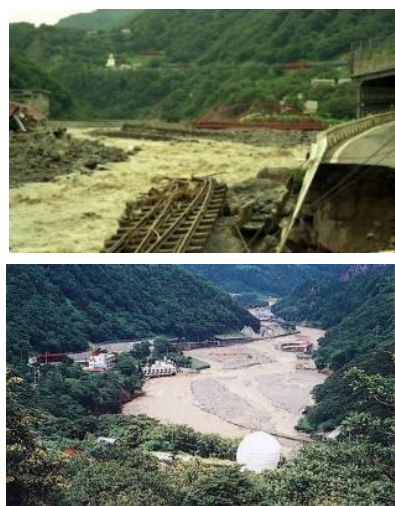
姫川温泉付近の被災状況
