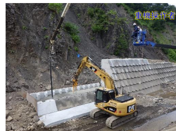
無人化施工（コンクリート工）
