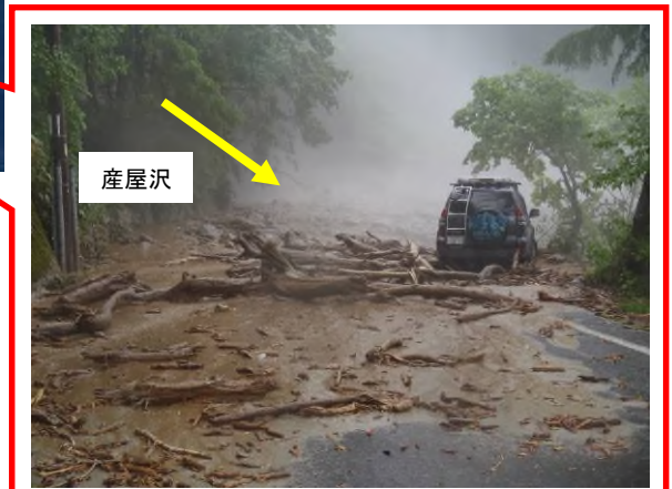
平成23年6月23日の出水では土石流が産屋沢橋を破壊。上高地全面通行止。
