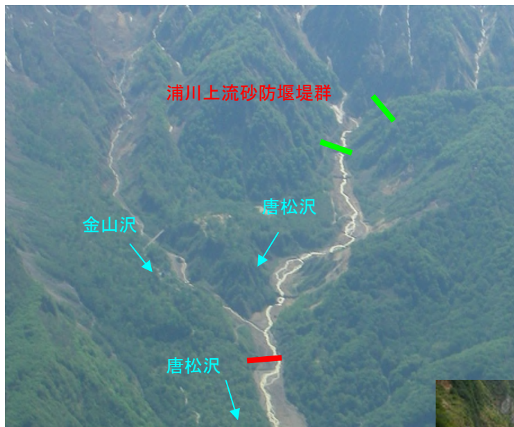
浦川上流砂防堰堤群全景
