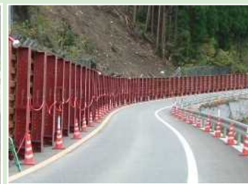
仮設防護柵工
