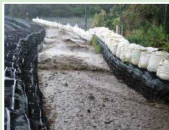
仮設導流堤工
