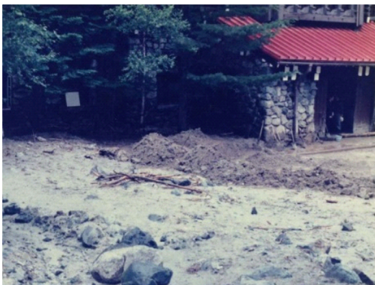
土砂災害の状況(昭和50年7月撮影)
