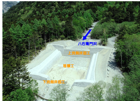
工事完成後(令和元年6月撮影)
