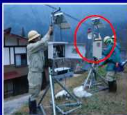
危険箇所を共有し、住民避難のため、サイレンと回転灯を設置
