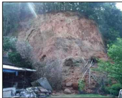
自然斜面崩壊状況(熊本県益城町)
