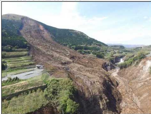
大規模な崩壊事例 (阿蘇大橋地区)
