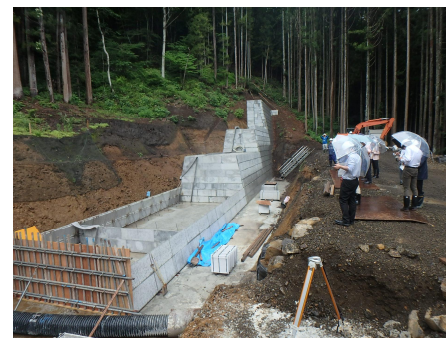
長野県による砂防堰堤の施工現場 （一本木沢、白馬村）視察協力：長野県姫川砂防事務所
