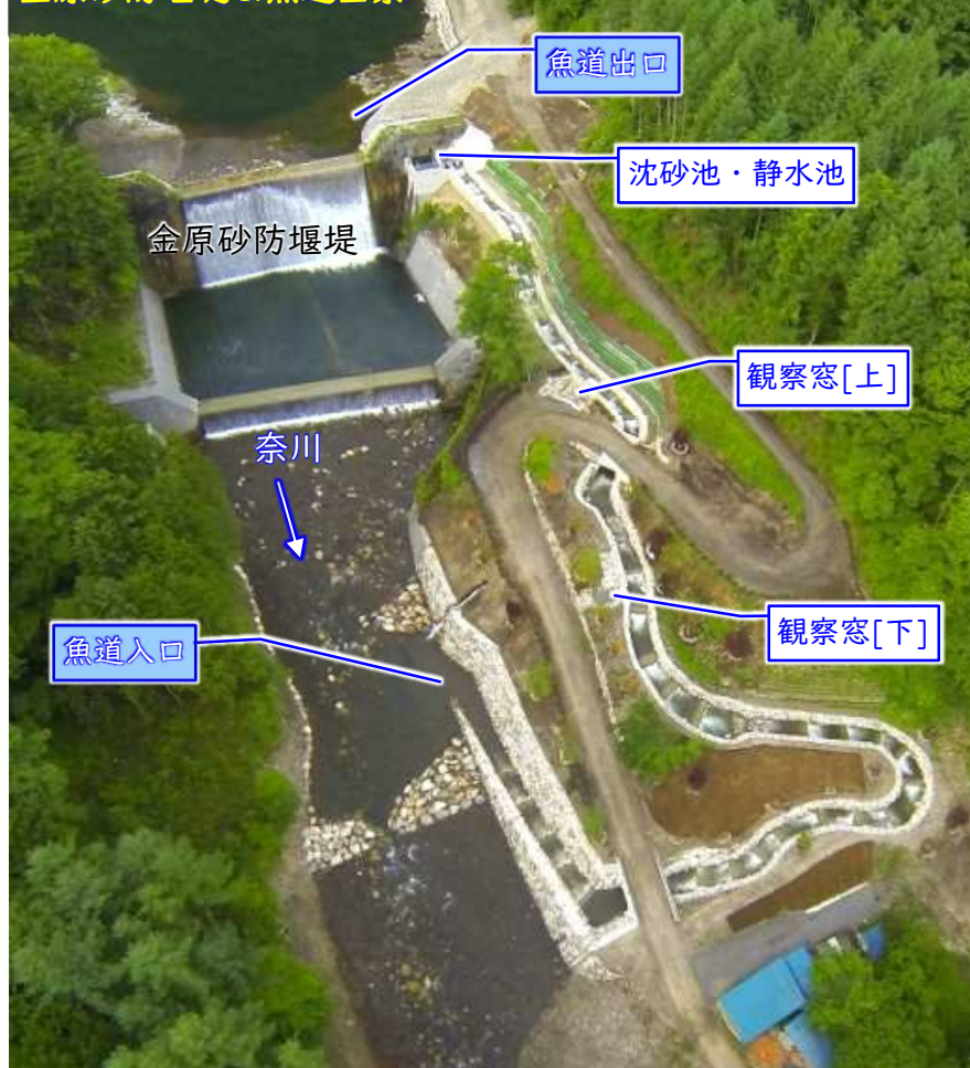
金原砂防堰堤&魚道全景
