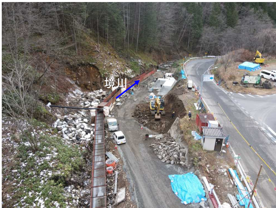
現場状況(境川)
