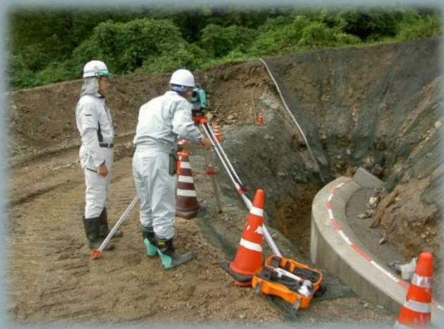
玉石積護岸 H=4.3mは、現地で採取した玉石を用い、景観に配慮した強固な護岸となっています。
