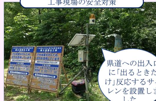
県道への出入口に「出るときだけ」反応するサイレンを設置しました。
