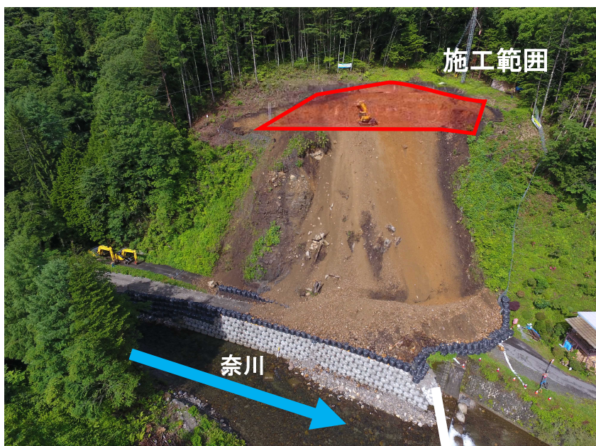
法面掘削状況(正面上空より)
