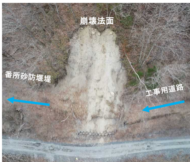
崩壊地着手前の状況
