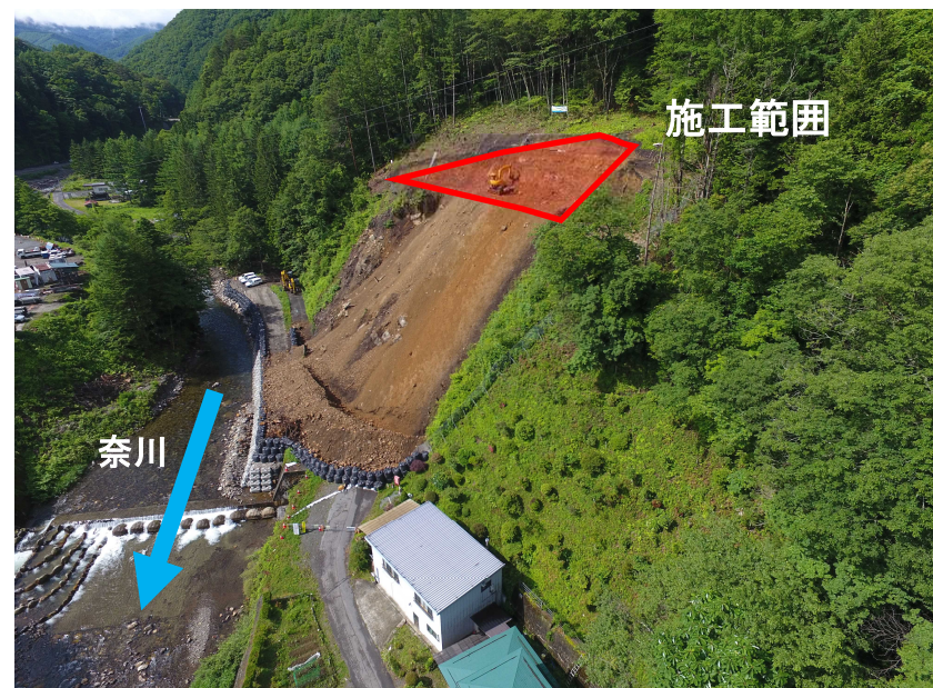
法面掘削状況(下流上空より)
