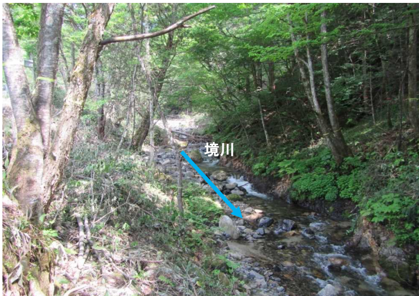
現場着手前の状況（伐採前）
