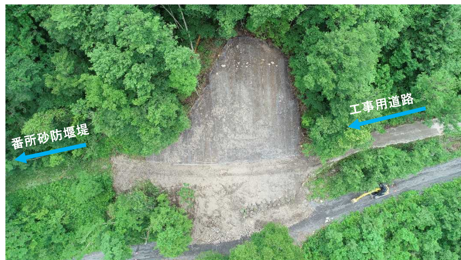
崩壊地の状況（法切・ラス網設置後）
