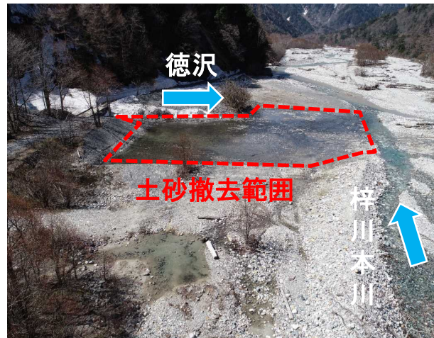
堆積土砂の掘削・撤去完了の状況 (撮影:R3年4月26日)
