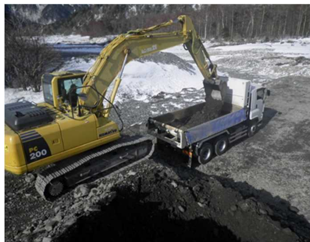
堆積土砂の掘削・積込みの状況 (撮影:R3年4月2日)
