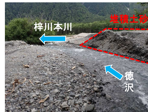
堆積土砂撤去前の状況
