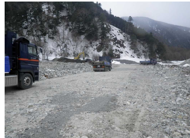
堆積土砂の運搬・搬出の状況
