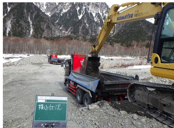
堆積土砂の掘削・積込みの状況②
