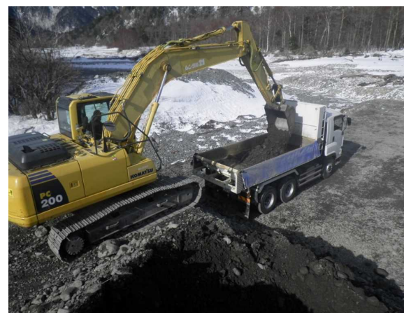
堆積土砂の掘削・積込みの状況①
