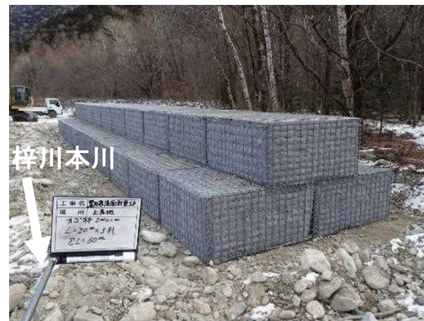
ふとんかご護岸本体の完成 (仮設工のため周辺樹木の伐採を行わないように設置)
