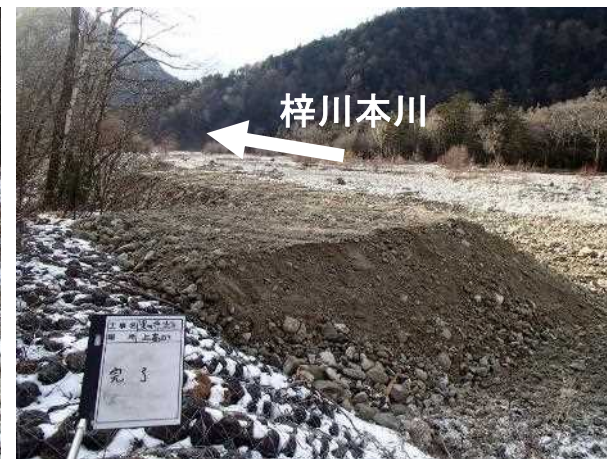
既設護岸との開口部を塞ぎ、修景を施して完成
