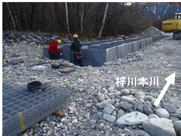
ふとんかご護岸を施工中の状況
