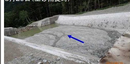
8月29日(土砂捕捉時)
