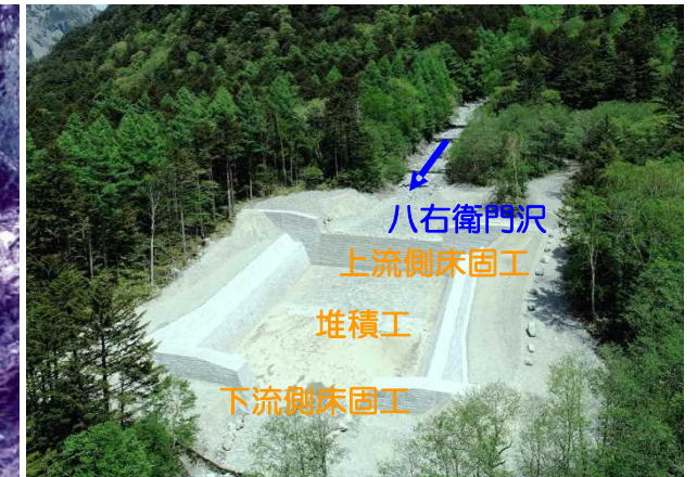
第2号堆積工完成後(令和元年7月撮影)
