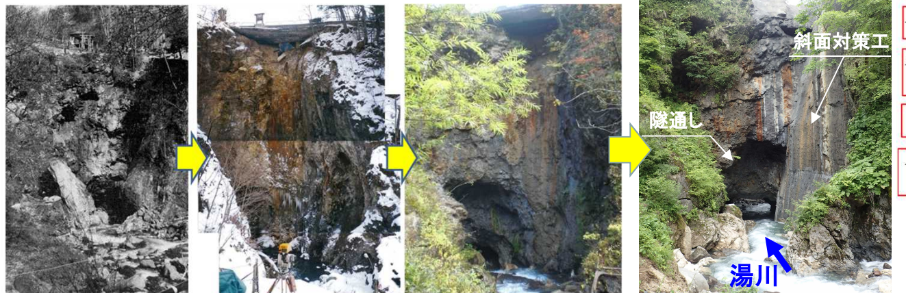
昭和40(1965)年頃 平成14(2002)年 平成25(2013)年 工事完成後(平成30(2018)年7月)
