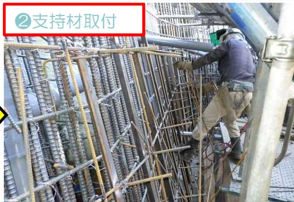
コンクリート擁壁に擬岩を設置するための鉄筋を取付け
