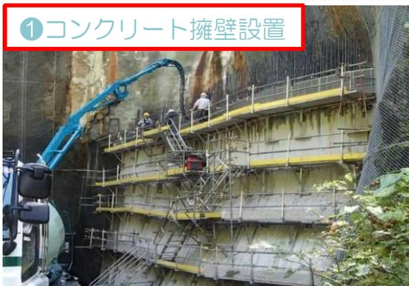
斜面の風化を防ぐためコンクリート擁壁を最初に施工
