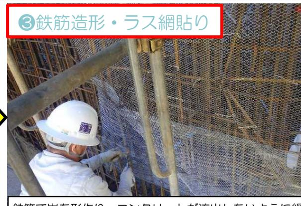
鉄筋で岩を形作り、コンクリートが流出しないように網を貼り付け
