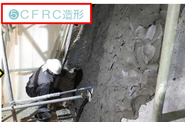
炭素繊維強化セメント(CFRC)を用い、全てを手作業で造形
