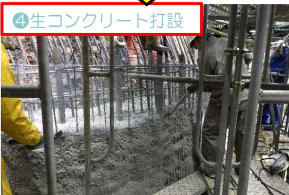
複雑な擬岩面に隙間なく充填するよう注意しながら打設
