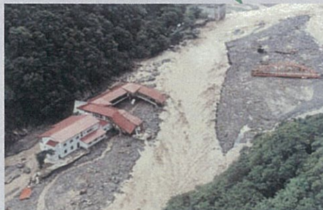
激流に襲われたホテルと土砂に埋まった橋
