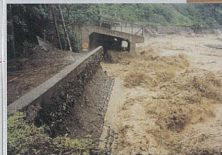
崩壊した小谷村北小谷の下寺洞門
