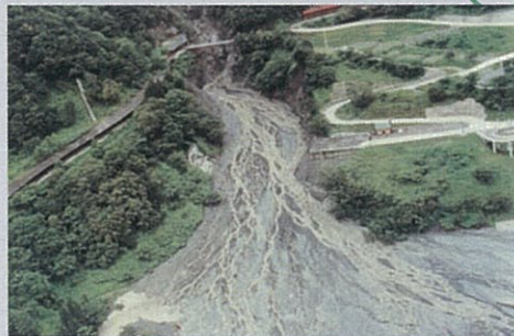
土石流により流出した新国界橋
