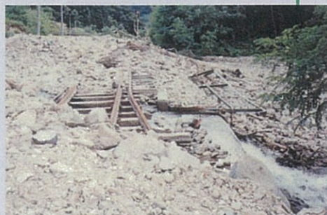
土石流に埋まった線路(北小谷深原)
