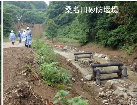
鋼製砂防牛柵水制(ブルメタル)
