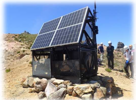
頂上付近の伝送、給電装置
