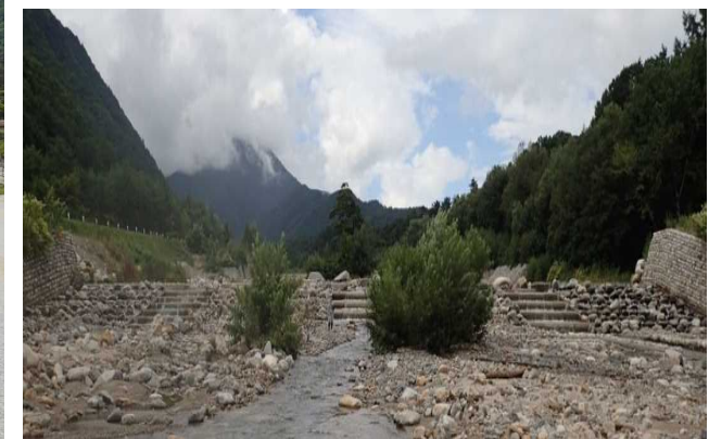
日向山第2号床固工(平成25年完成)
