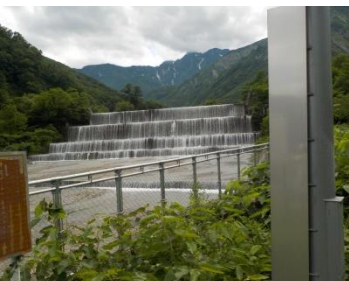
⑬源太郎砂防堰堤の様子
