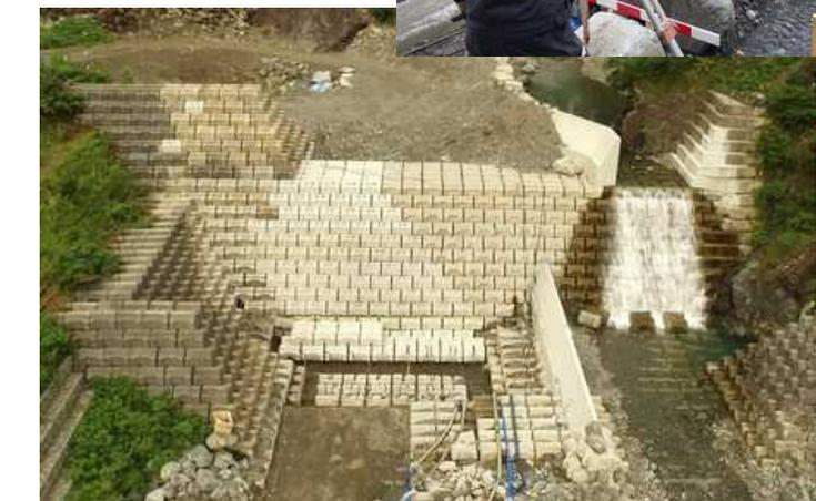
④全景。当現場は比較的大きな地すべり地形を抱えていたため、地盤の変状に構造物が対応できるブロック積み堰堤です。本工事ではその部分的に老朽化したブロックの更新を行っています。
