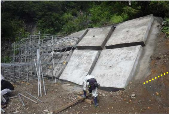
⑤当現場の法面対策工の一つ、アンカー工です。堰堤施工箇所に地すべり地形があります。この地すべり地形を地盤に固定するためのワイヤーケーブルを地中深くに固定し、更にワイヤーの緊張を行い写真の受圧板で緊張荷重を引き受けさせることで地盤と地すべり地形を一体化します。
