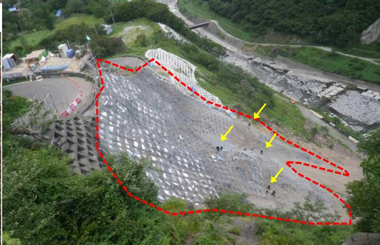
④現場全景。赤い囲みが施工範囲です。命綱を張って急斜面に施工する法枠工の鉄筋を組立えています。（矢印は全て作業を行う人です）
