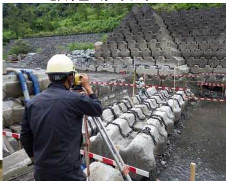
当現場は既設ブロック堰堤の摩耗損傷部を撤去し、新規ブロックにて断面復旧を行う工事です。昨年度は左岸側を施工し、今年度は右岸側を施工しています。ブロックは挿入鉄筋位置の違いや再利用する・しないにより種類が多く、選別と据付場所の管理に四苦八苦しています。
