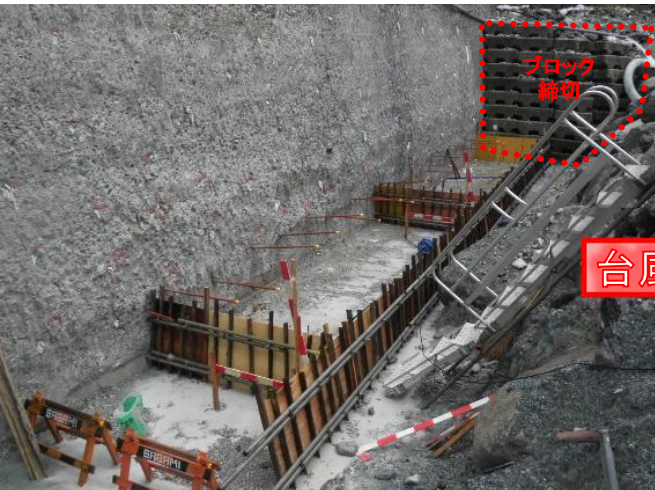
⑤台風通過後は大量の流水で打設予定箇所が土砂と流水で埋まりました。
