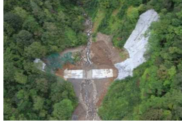
②上空からの現場状況。右側の白い部分が崩落対策。地山がもろい現場というところがうかがえます。
