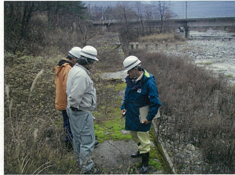
クラック状況の確認
