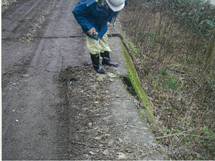
平川流路工(護岸工)の点検
