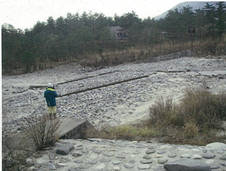
平川流路工(帯工)の点検
