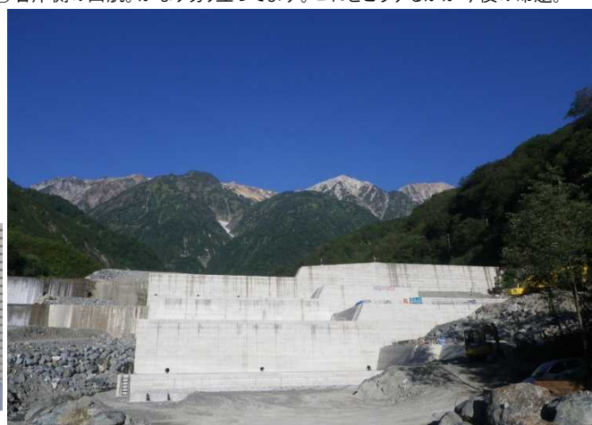
④白馬三山をバックにそびえ立つ南股上流砂防堰堤(左岸側施工部)
