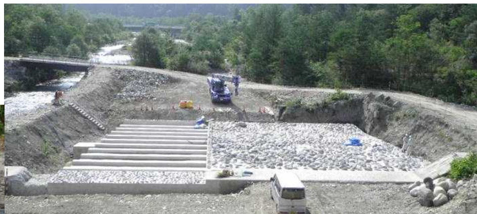
④渓流再生工全景。川底を固定する床固め工の施工。床固めだけでは段差ができてしまい、水中生物の往来ができません。そこで、職人さんによる石張り技術により、平川の自然景観にマッチする魚道を創出します。オリンピック大橋から現場を見ることができます。
