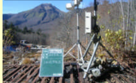
②土石流センサー
