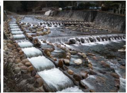
魚道の設置後(平成 22 年 12 月完成)
