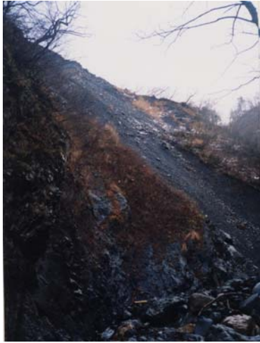
支川ウド川の崩壊斜面
