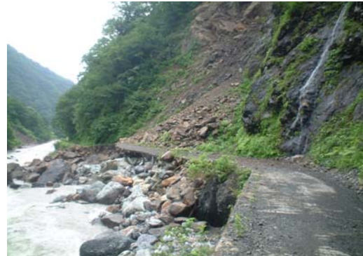
霞沢（松本市）での被災状況
