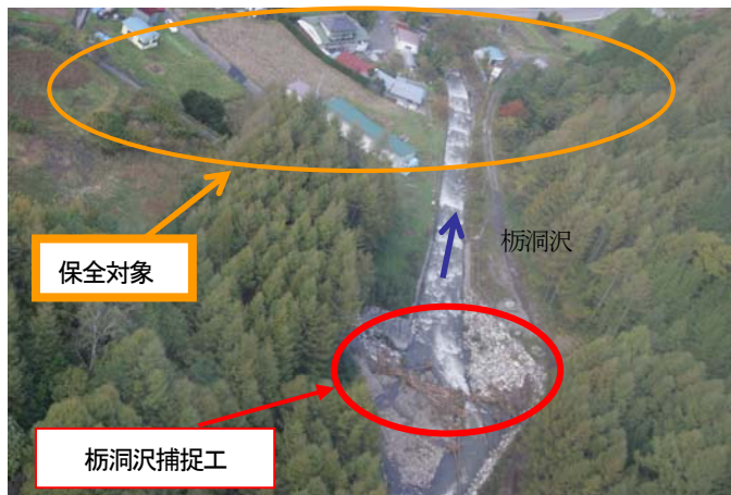
施工施設の効果事例
