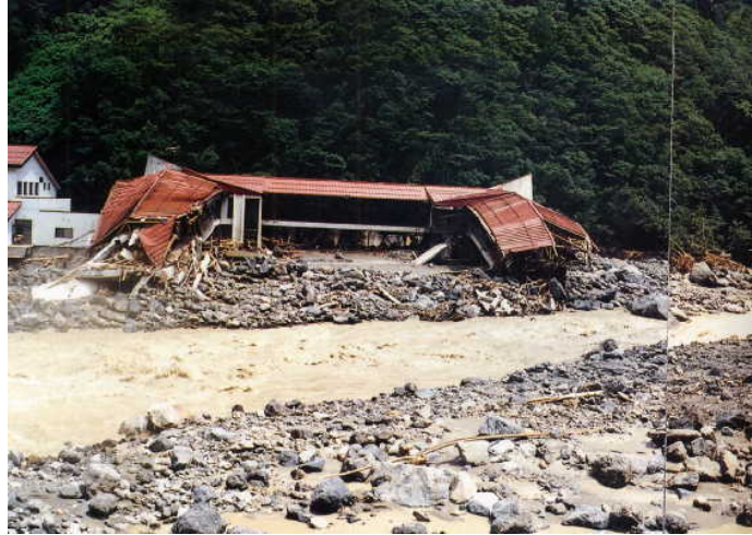
濁流にのまれ壊されたホテル国富（平成7年7月）
